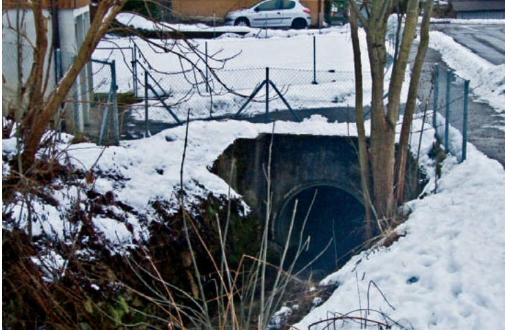
De tels rétrécissements sont très dangereux lors des crues, car le bois charrié peut obstruer le passage. (Photo: Canton de Fribourg)
