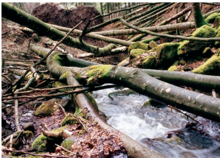
Les arbres situés dans le lit des ruisseaux peuvent former un bouchon (occlusion) et causer des inondations. (Photo: R. Schwitter)
